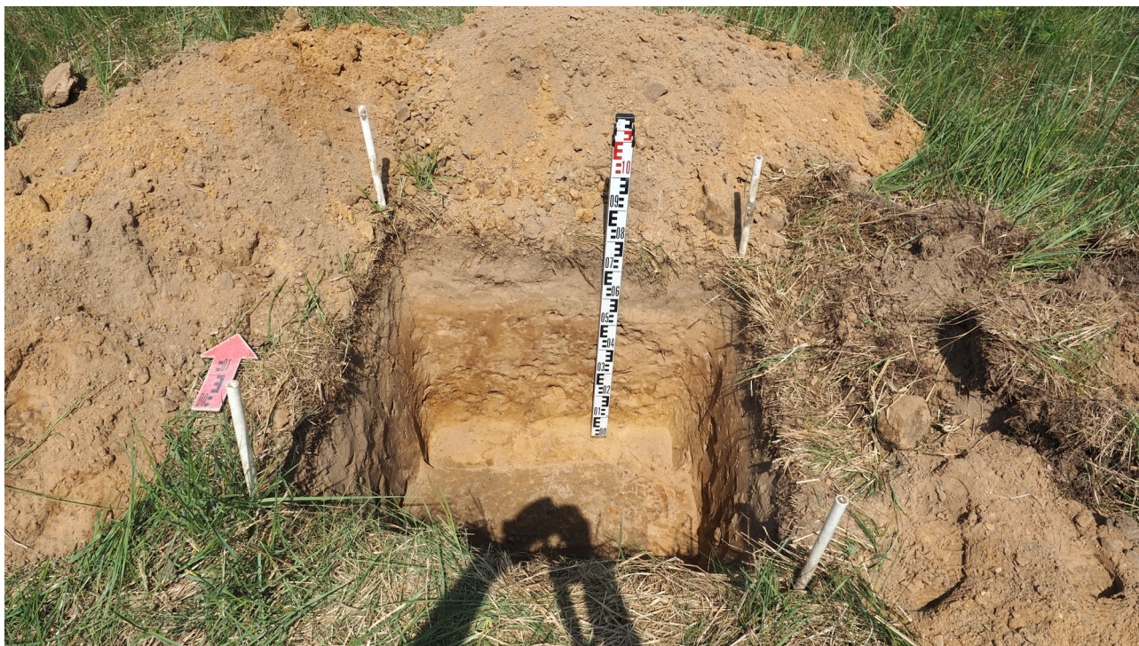
Рис. 30. Калужская область, Думиничский район. 2023 г. Археологическое обследование по объекту: «Уличные газопроводы дер. Кожановка». Шурф 3. Северная стенка с контрольным прокопом. Вид с юга.
